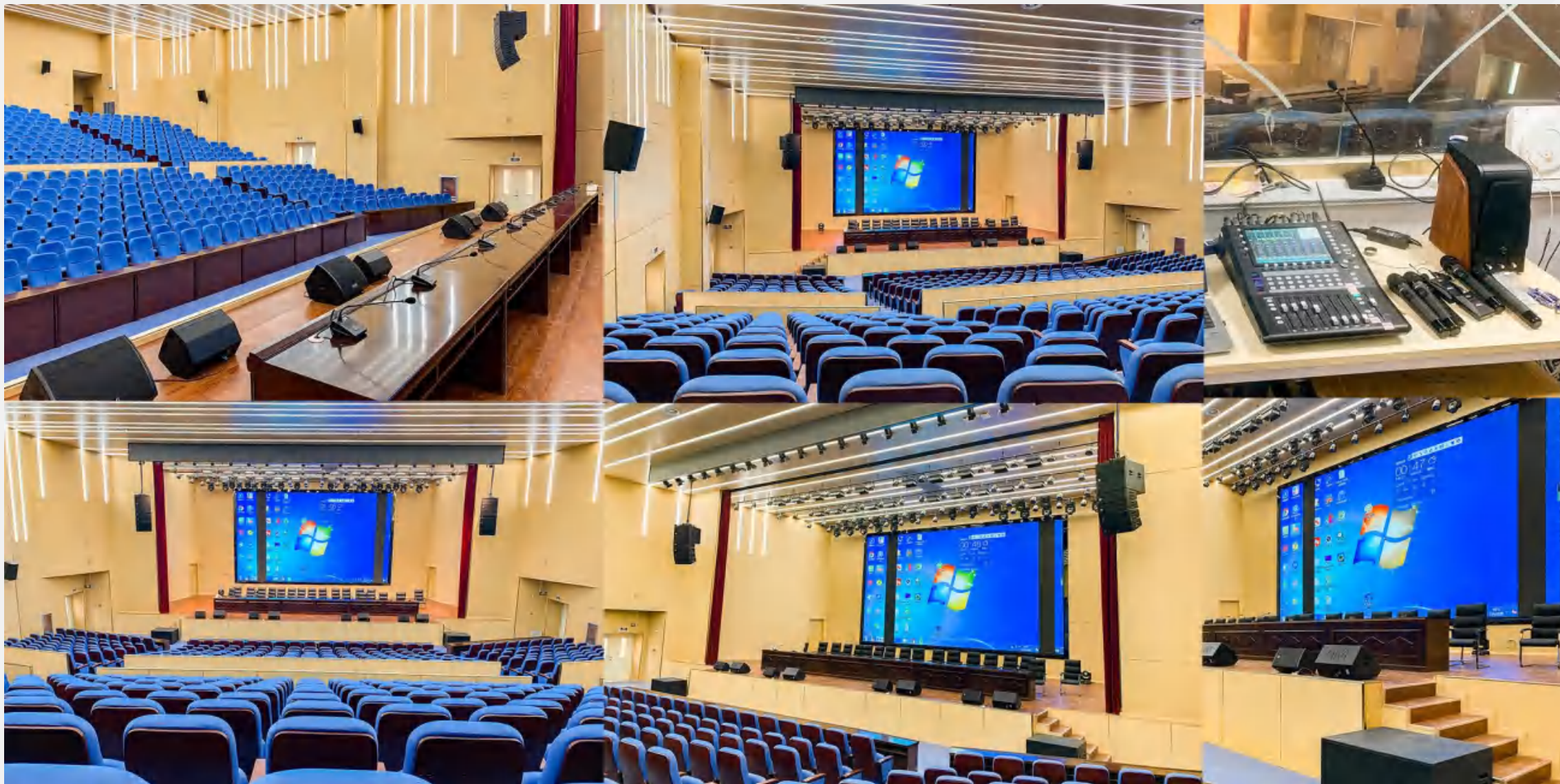
淄博市沂源县人民医院——报告厅音响系统
