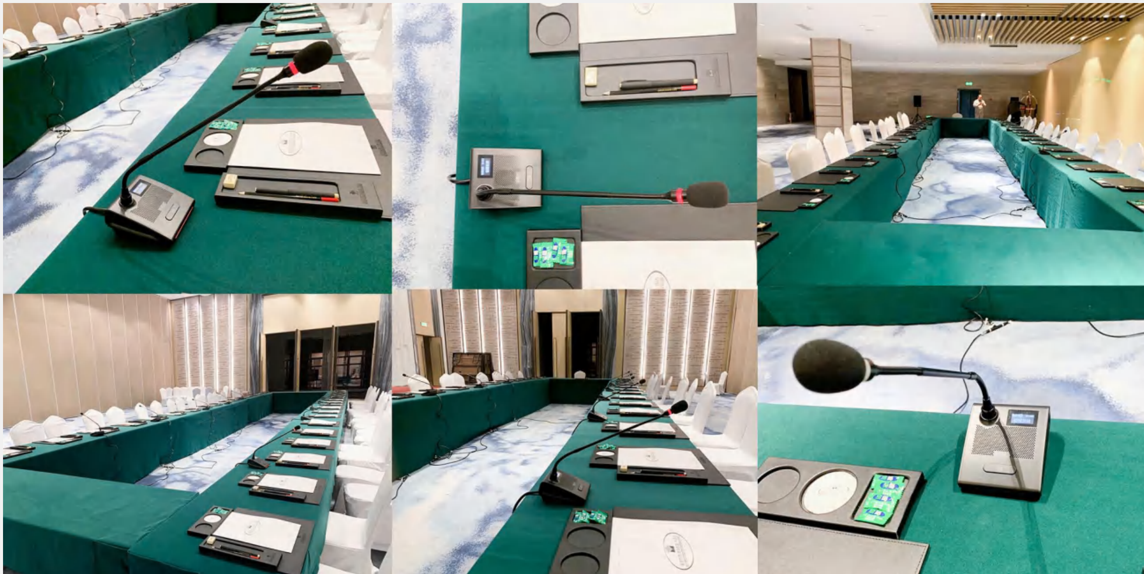
青岛海景花苑大酒店5个会议室——会议室音响系统
