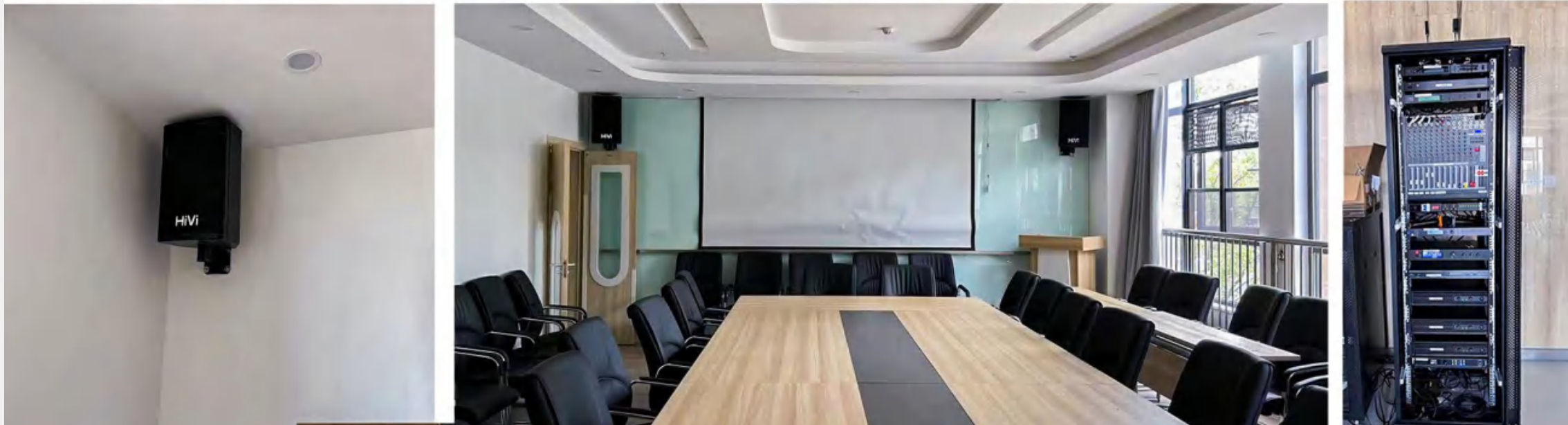
南京江北新区启慧幼儿园——会议室音响系统
